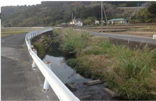
下流部分の市道の沈下
