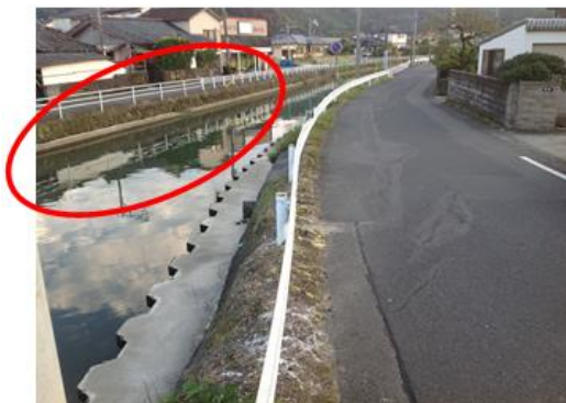
下流部分の市道の沈下
