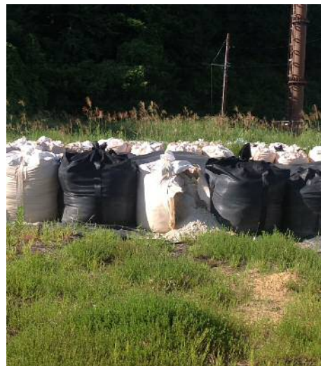
役場敷地内の放射能汚染土砂仮置き場
